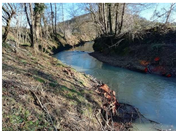
Travaux sur le bassin du Saleys
