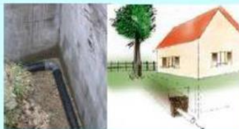
Drains de fondation
