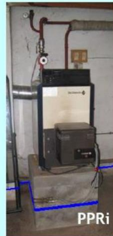
Rehausse de chaudière...
