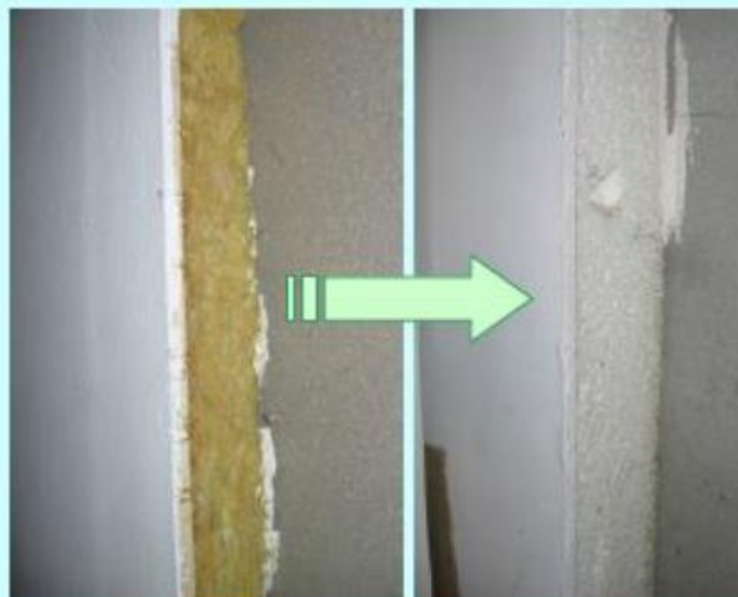
Changement des matériaux d'isolation
